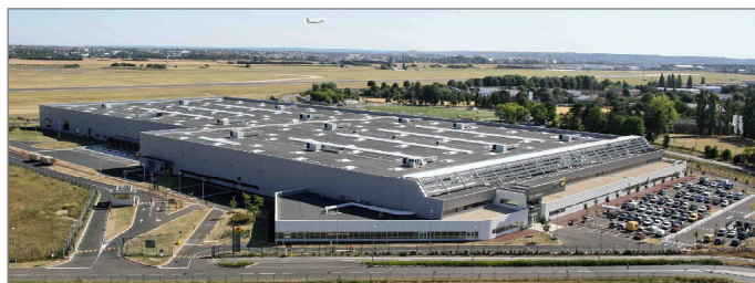
Vue aérienne de la PIC de Wissous.
